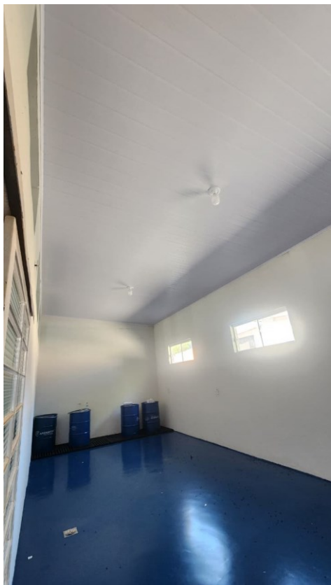
Figura 11 Forro PVC Sala de embalagem vazia
